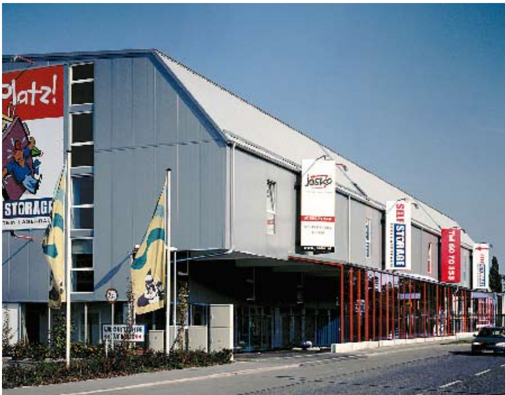
A, Vienna, SelfStorage – Dein Lagerraum, Grenzackerstrasse
