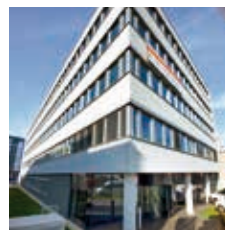
Franzosengraben Office, Vienna
